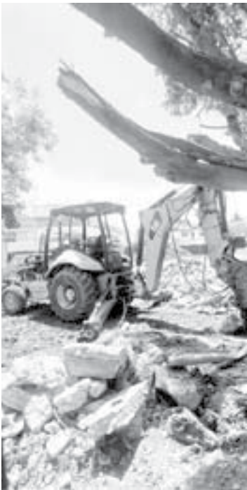
Aspecto de los obras de construcción del parque recreativo Bonampak. CP
