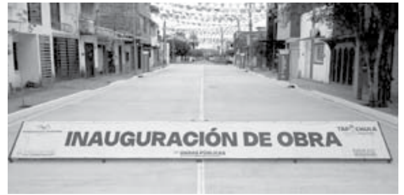
Se inauguró la obra de la 9.ª calle Oriente, entre la 9.ª y la 11.ª avenida Norte, en la colonia Barrio Nuevo. Cortesía
